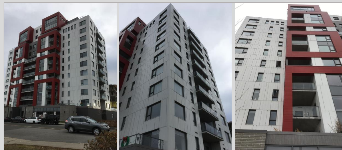
Figura N° 1: Edificio Origine Condos, Canadá. Fotografía: archivo INFOR.
